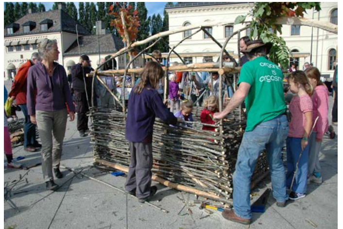
Ferske, unge, slanke rognetrær ble benyttet til flettingen.
