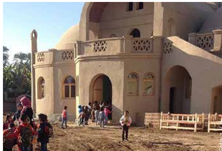
Kindergarten Hebet el-Nil: Architekt Christian Hitsch
